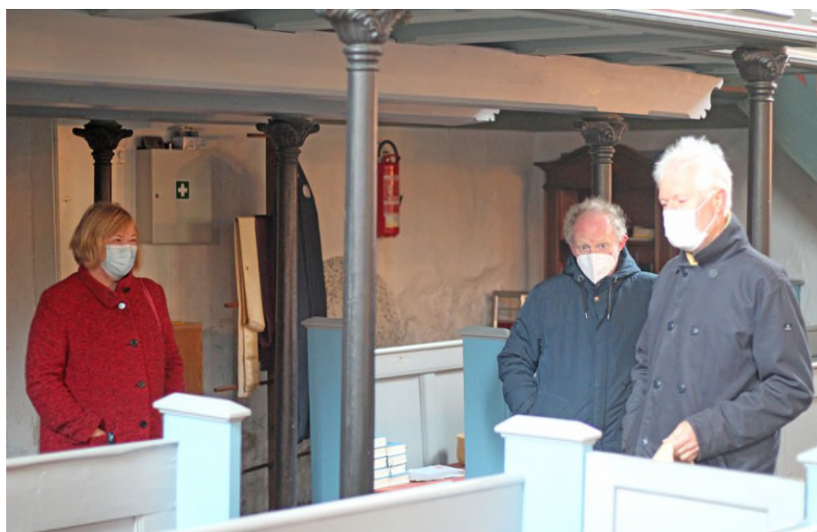
Architekt Torsten Ewers (r.) erklärte Bettina Hagedorn und Pastor Dr. Martin Grahl die umfangreichen Sanierungsarbeiten.
